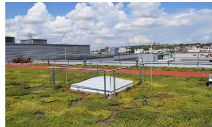
Dachbegrünungen sind i.d.R. „Gegen Flugfeuer und strahlende Wärme widerstandsfähige Bedachungen“ = „Harte Bedachung“.
